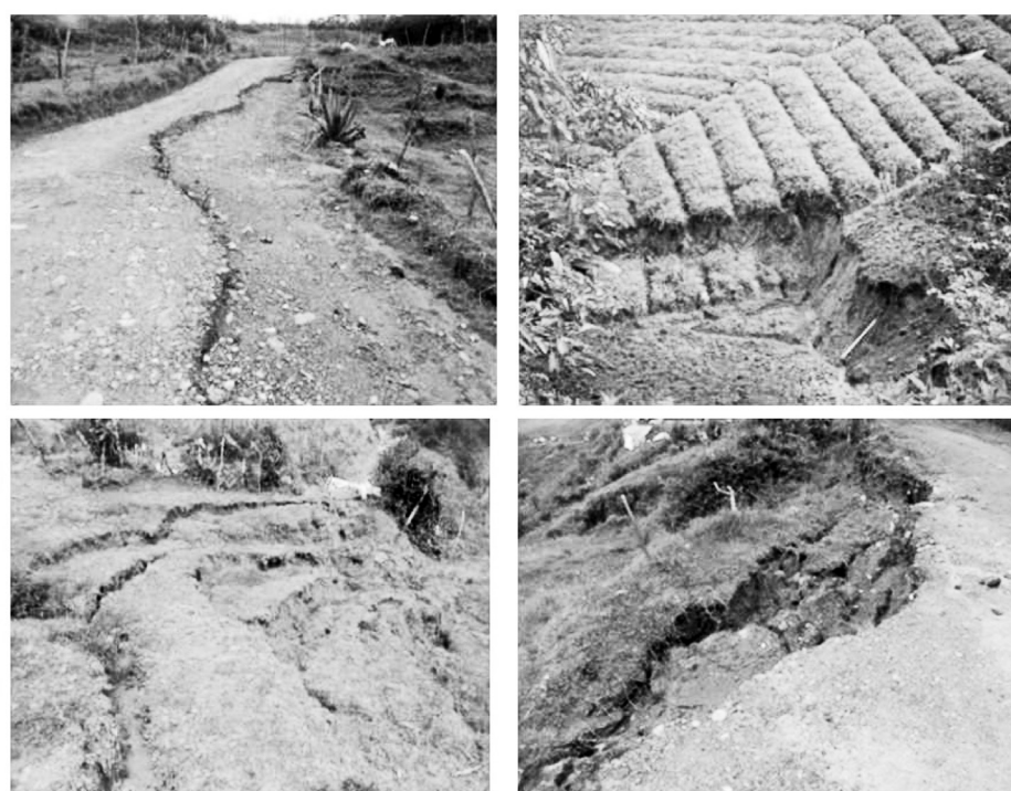
Figura 3. Diferentes hundimientos en municipio de Marinilla.
